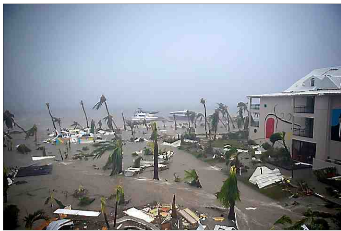
▶ Irma. Quatre lettres pour une catastrophe naturelle sans pareille. L'ouragan a dévasté les îles françaises de Saint-Barthélemy et Saint-Martin, le 6 septembre. Sur cette dernière, détruite à 95 %, tout a été soufflé, y compris les locaux de la préfecture.
